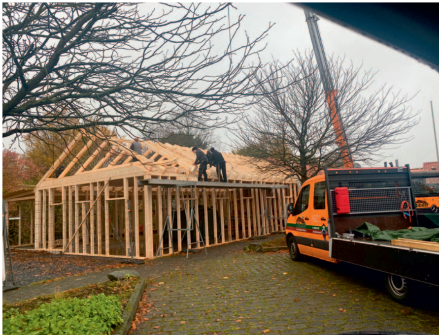
Das Trolleyhaus des GCUF wird aus Kapazitätsgründen erweitert; das Foto zeigt den Stand der Bauarbeiten Mitte November. Foto: F. Kämmerling.
